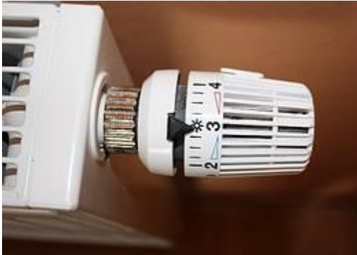
Thermostatregelung eines Wohnungsheizkörpers.
